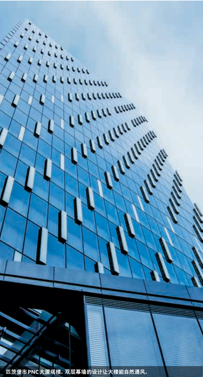
匹茨堡市 PNC 大厦塔楼。双层幕墙的设计让大楼能自然通风。
